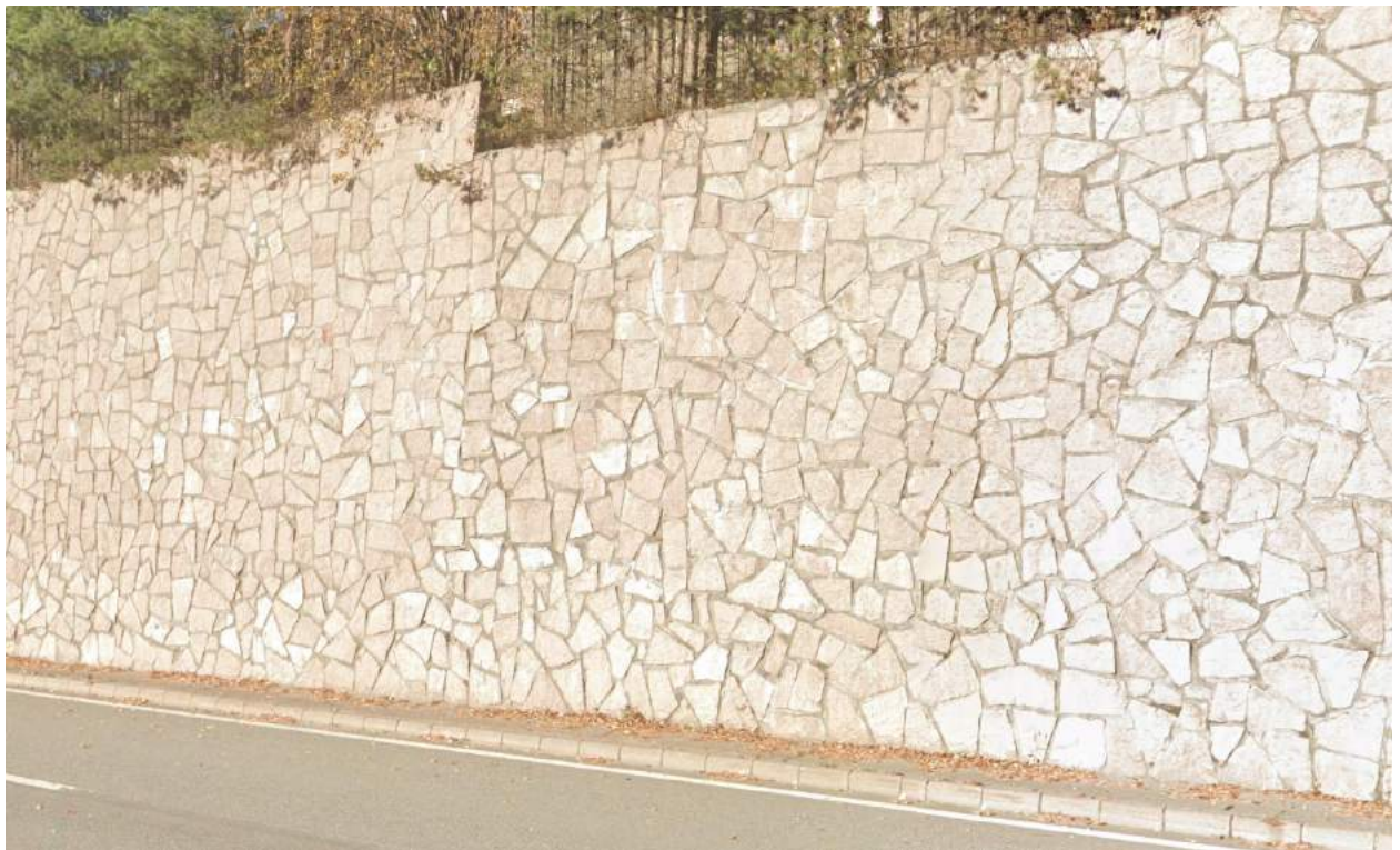
Eksist. støttemur ved Strand (nordside av opprinnelig E18)
